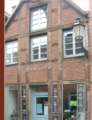
Kirchstraße Durch die neue Ausmauerung der Fassade dieser alten Seilerei konnten Geschichte und Wohnansprüche der Gegenwart vereint werden.
