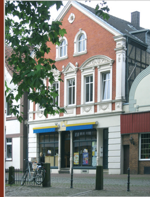
Mühlenstraße Die aufwändig gestaltete Fassade dieses Ende des 19. Jh. gebauten Fachwerkhauses entsprach dem Geschmack der wilhelminischen Zeit.
