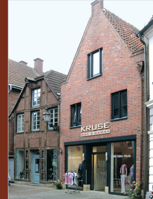
Kirchstraße Bei der Fassade des rechten Hauses hat man die früher bei Feldbrandsteinen üblichen Unterschiede im Farbton der Steine wieder aufgegriffen, wodurch die Wand glatt aber keinesfalls langweilig wirkt.
